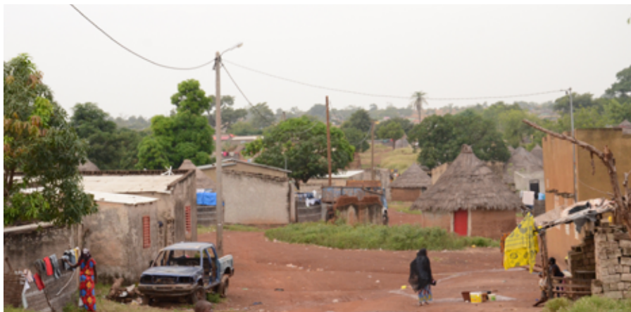
Extension du réseau électrique au quartier Pasteur Bitler à Kédougou
